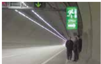
Signalisierung der Fluchtwege
