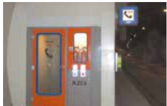
Notruftelefone und Feuerlöscher der orange markierten Pannbuchten
