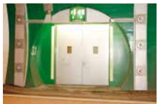
Grün markierte Notausgänge mit Notruftelefon und Feuerlöscher
