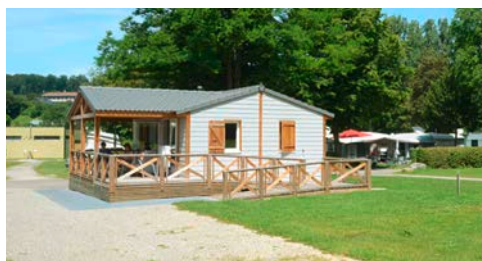
Bungalow avec accès pour fauteuil roulant.
