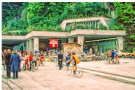
Am Tag der «offenen Baustelle» 1980 konnte der Tunnel mit Velos durchfahren werden.
