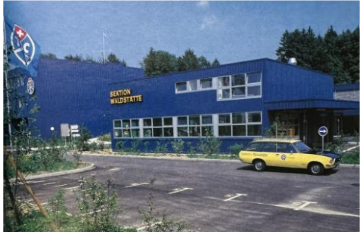
Das Prüfzentrum in Emmen in einer Aufnahme von 1986.
