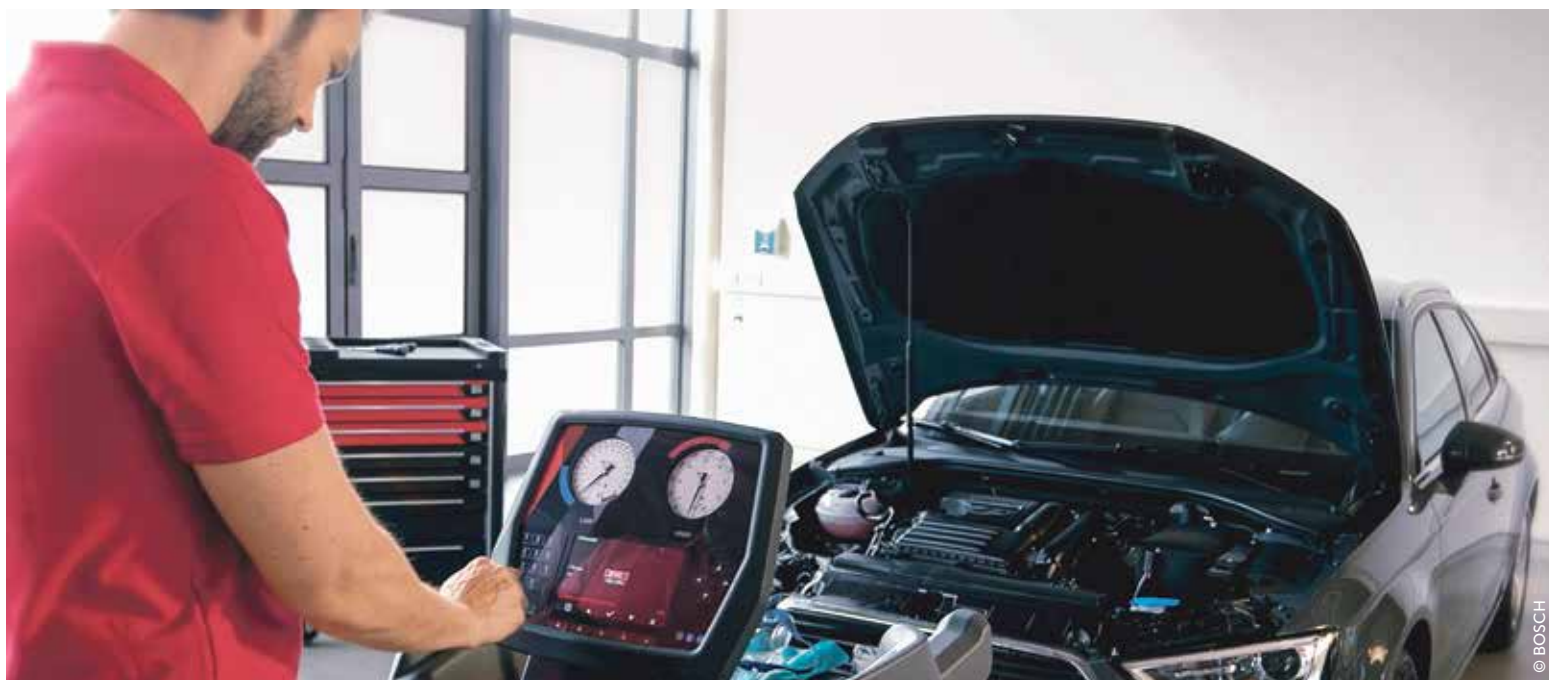
Il y a lieu de nettoyer en profondeur le système de ventilation chaque année.
