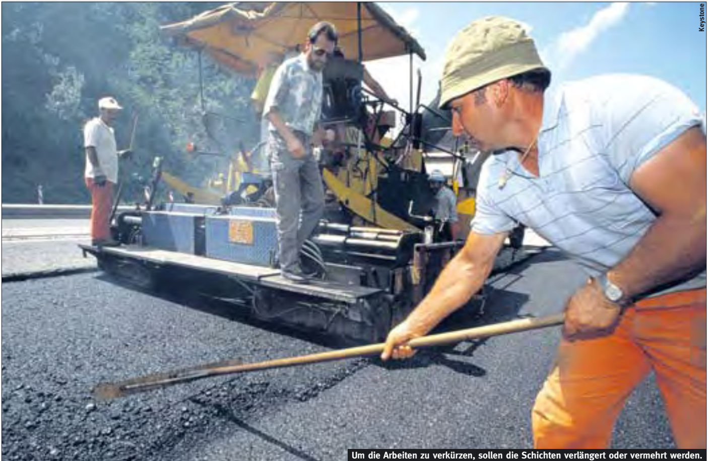
Um die Arbeiten zu verkürzen, sollen die Schichten verlängert oder vermehrt werden.
