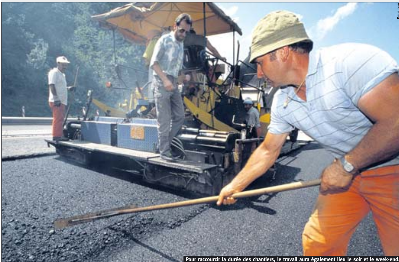
Pour raccourcir la durée des chantiers, le travail aura également lieu le soir et le week-end.
